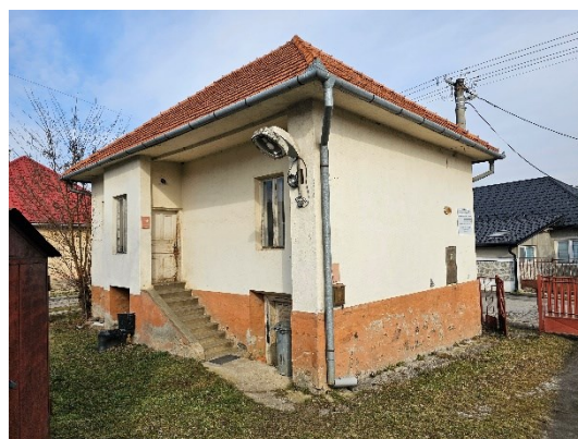
Pohľad z dvora
